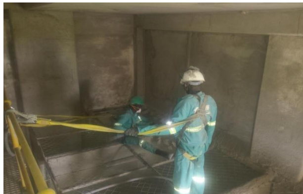
IMAGEM 18: Limpeza de tanques e silos (Cimentos de Moçambique).
