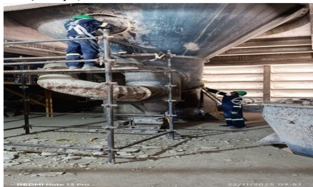
IMAGEM 28: Remoção de tampas e limpeza do ciclone (Cimentos de Moçambique).
