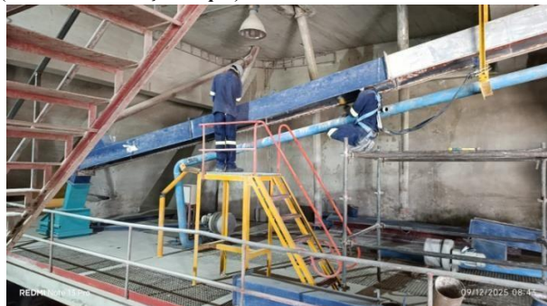
IMAGEM 24: Remoção e limpeza das caleiras do moinho (Cimentos de Moçambique).
