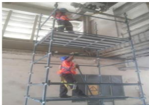
IMAGEM 08: Fabrico e montagem de estrutura metálica.
