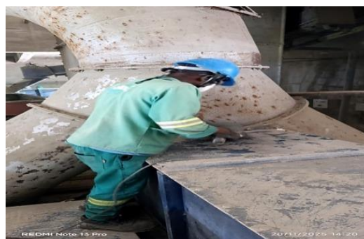
IMAGEM 29: Limpeza no armário do filtro (Cimentos de Moçambique).
