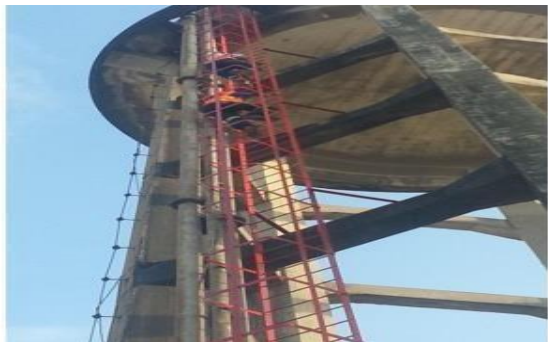
IMAGEM 07: Intervenção em estrutura elevada e manutenção industrial.
