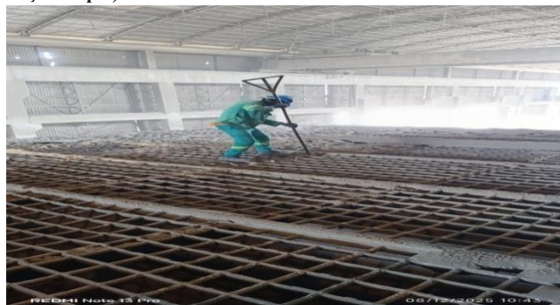
IMAGEM 26: Remoção de calcário das tremonhas (Cimentos de Moçambique).
