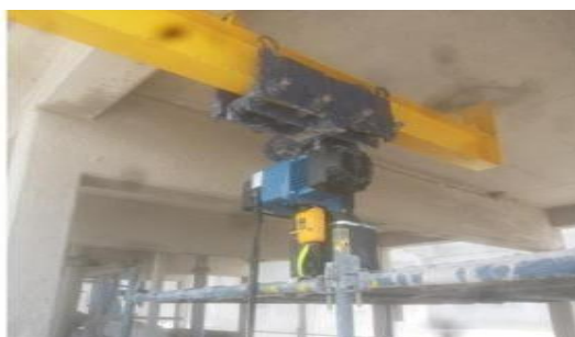
IMAGEM 12: Montagem de guincho em ambiente industrial.
